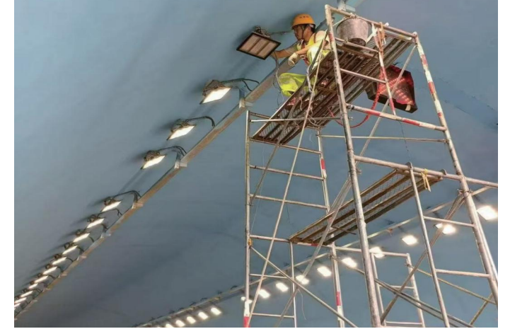
兰海高速贵州段隧道项目 Lanhai Expressway Guizhou section tunnel project
