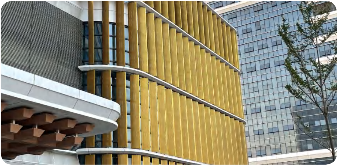
外幕墙百叶 EXTERNAL CURTAIN WALL LOUVERS
