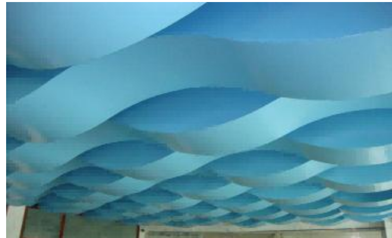
建筑天花系统
